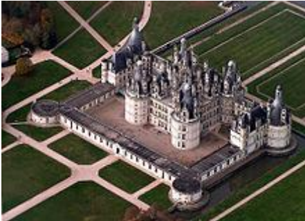
6.10 Άποψη του Chambord [Πηγή: Wikipedia ]
